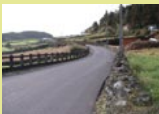
Ramal da Manhenha (Piedade)
