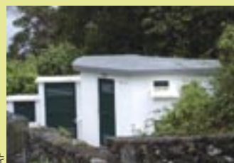
AP Reservatório de água de S. João
